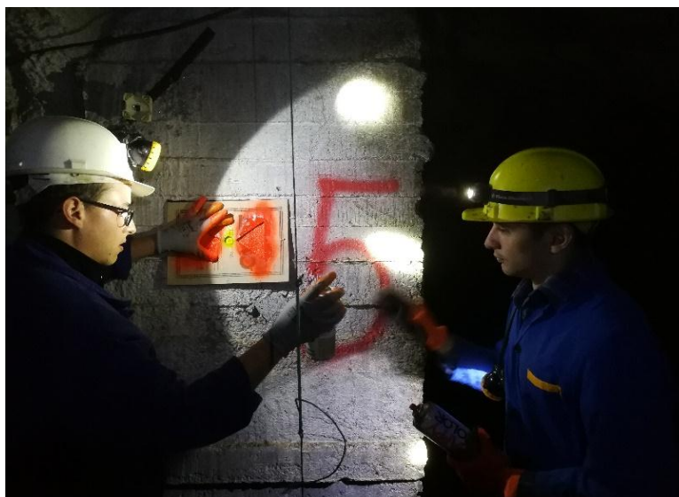
Фиг. 2. Сигнализиране на опорна точка
